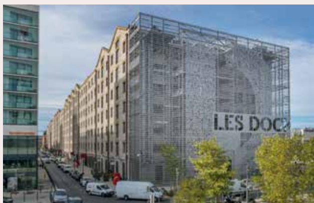
Les Docks, 10 place de la Joliette, 13002 Marseille
